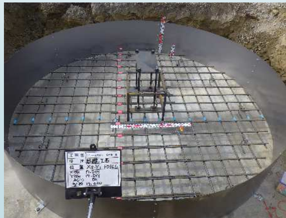
基礎配筋 出来形→
