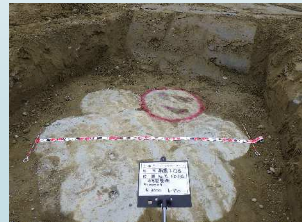
地盤改良 出来形→
